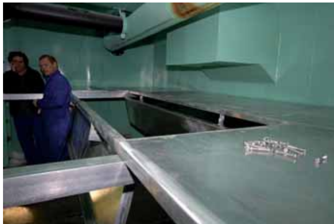
Figur 4. Etasjebunn under montering i styrbord rom.
